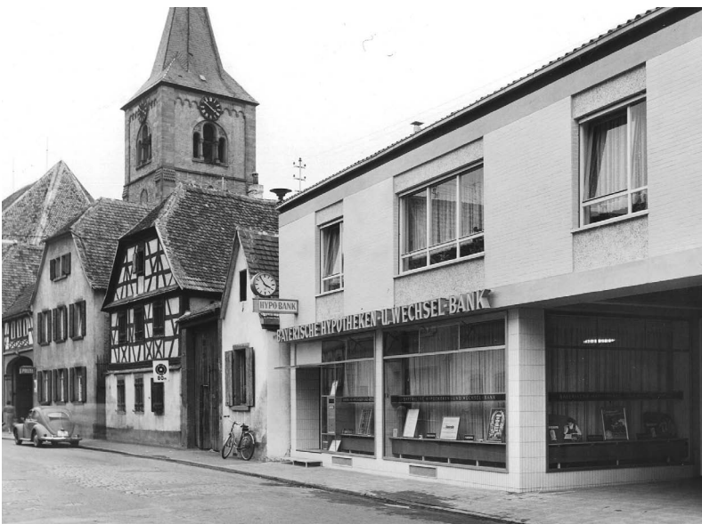
Außenansicht der Hypo-Bank-Filiale im November 1960
