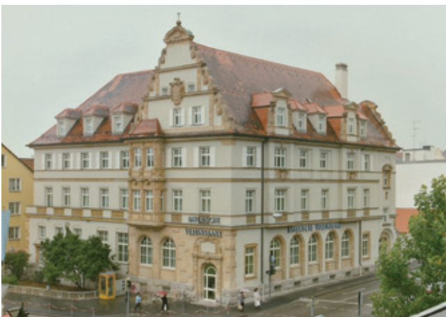
Außenansicht der Bayerischen Vereinsbank-Filiale in der Bahnhofstraße 1989
